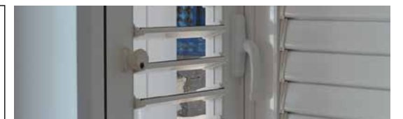
Mécanisme d'ouverture à lame orientable persiennée.
