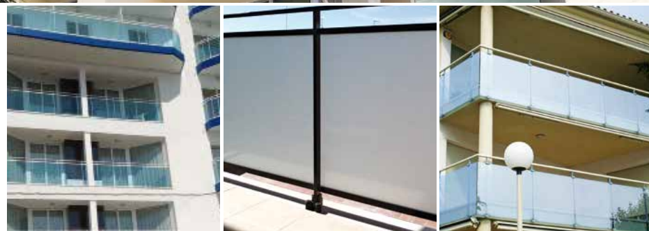
Garde-corps avec vitrage.
